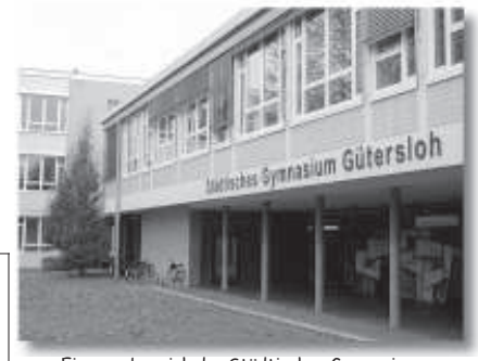
Eingangsbereich des Städtischen Gymnasiums
