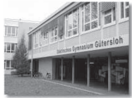
Eingangsbereich des Städtischen Gymnasiums
